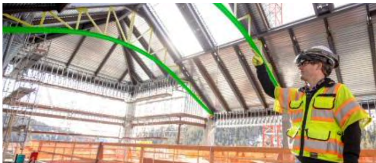
Figura 26 - Applicazione di Mixed Reality in situ tramite Trimble XR10 dotato di Microsoft HoloLens 2 (Fonte: geoweeknews.com)
